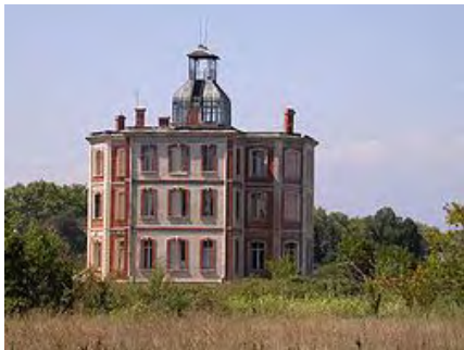
Edifici original abans de la restauració
